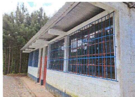
Foto 4: Balcones instalados. Aula 1 y 2.
