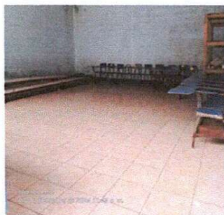
Foto 5: Piso cerámico instalado. Aula 1.
