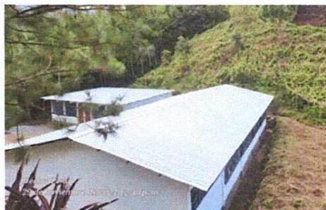
Foto 8: Techo instalado. Aula 3, 4, dirección y bodega.
