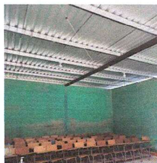
Foto 2: Techo instalado. Aula 2.
