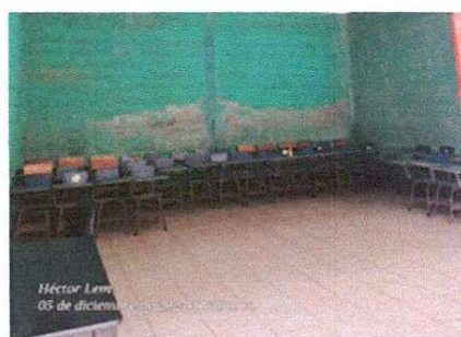
Foto 6: Piso cerámico instalado. Aula 2.
