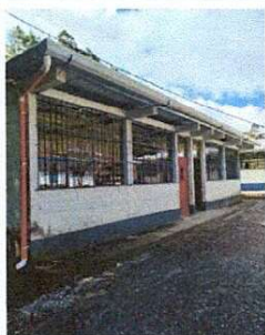
Foto 9: Canal instalado. Aula 1 y 2. 13 ML.
