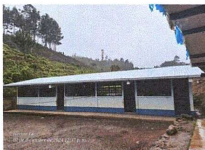
Foto 10: Sustitución de canal PVC por aluzinc. Aula 3, 4, dirección y bodega. 20.50 ML. Terminado.
