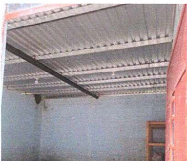
Foto1: Techo instalado. Aula 1.
