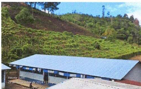
Foto 7: Techo instalado. Aula 3, 4, dirección y bodega.
